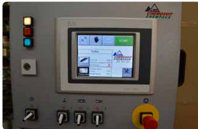
Obr. 2 Pohľad na ovládací panel – Power Panel 420 od spoločnosti B&R
