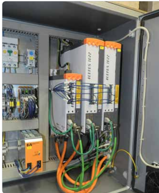
Obr. 5 Digitálne servozosilňovače ACOPOS™ od B&R riešia zložité polohové i logické úlohy s maximálnou dynamikou.
